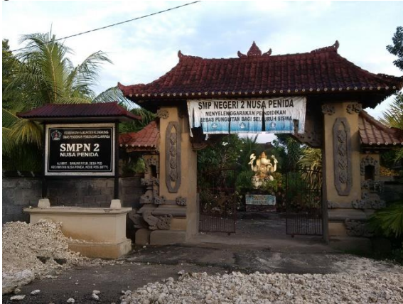
Gambar 1. Kondisi SMPN 2 Nusa Penida
