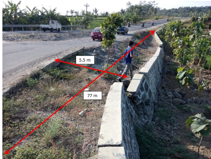
Gambar 4. Kondisi tanah longsor di ruas jalan Gunung Tugel Banyumas.
