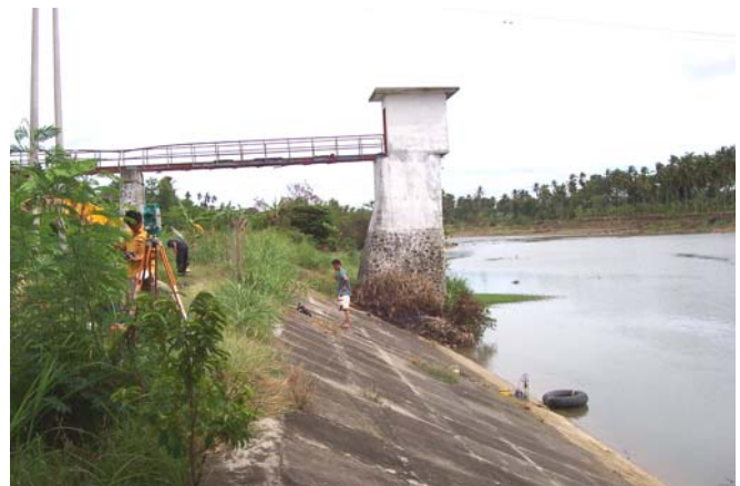
Gambar 1. Bangunan tempat pemasangan alat pengamat tinggi muka air tipe pelampung milik Dinas PSDA NAD
