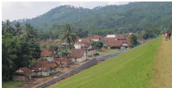
Gambar 2. Permukiman padat penduduk yang berada langsung di bawah tanggul Waduk Penjalin ke arah timur
