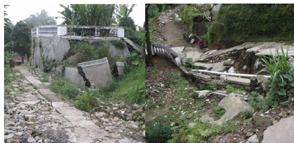
Gambar 2. Jalan dan permukiman penduduk yang selalu rusak akibat mengalami tanah longsor di Dusun Guyon, Desa Tengklik, Kecamatan Tawangmangu.
