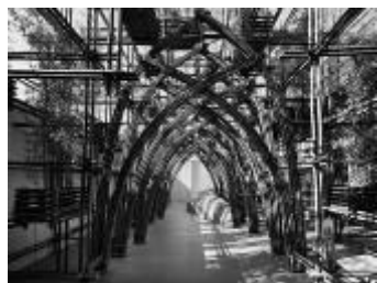
Gambar 3. Naungan yang diolah dengan mengeksplorasi tektonika bahan bambu
