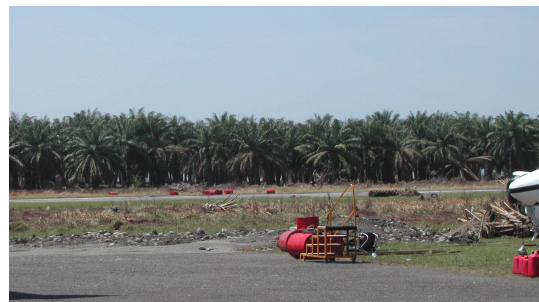
Gambar 4. Perlindungan kawasan Bandara Cut Nyak Dien dengan pohon kelapa yang berlapis dengan pohon kelapa sawit sangat membantu dalam meredam kerusakan yang terjadi.
