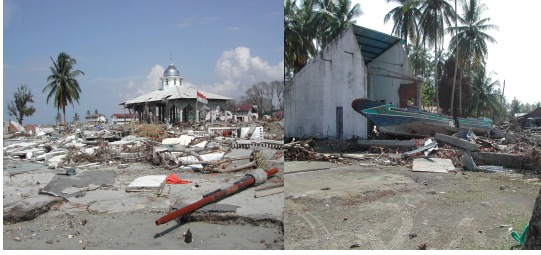
Gambar 3. Bangunan yang sebagian besar hancur rata dengan tanah dengan menyisakan bekas bangunan masjid di daerah Ujung Karang (atas), dan permukiman penduduk padat yang hancur terlihat bangkai kapal yang terdampar sampai sejauh 1 km dari garis pantai (bawah) di pantai Kota Meulaboh.
