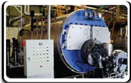
Gambar 1. Hoiken Boiler Cap. 5000 Kg/h (Sumber: PT XYZ)
