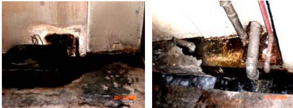
Gambar 1. Lokasi berkembang biaknya jamur dan bakteri dalam ruang parkir bawah tanah
