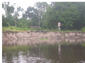
Gambar 2. Pinggiran Sungai Siak di desa Sigentil yang sudah tererosi
