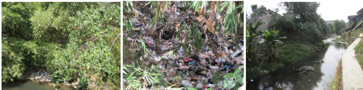
Gambar 1. Kondisi tepi Sungai Winongo di sebagian Kota Yogyakarta
