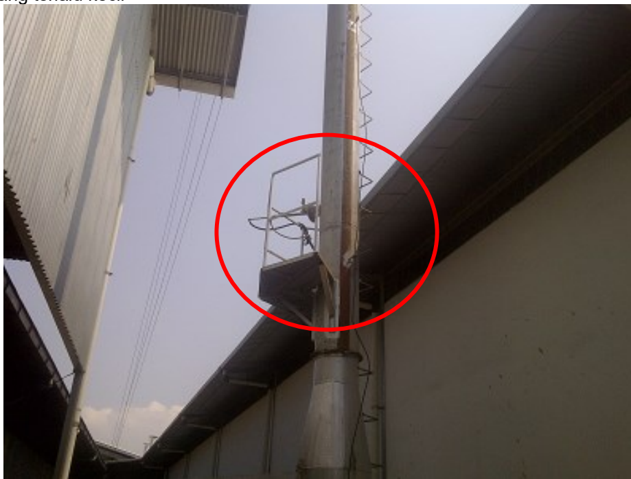
Gambar 8. Penampang Bordes yang Terlalu Kecil
