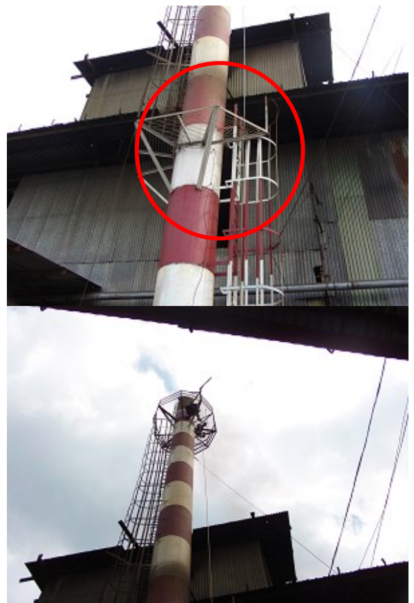
Gambar 7. Penampang bordes dan tangga yang keropos (BBTPPI, 2013)
