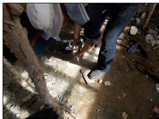
Gambar 8. Uji Hammer Test Pelat Lantai
