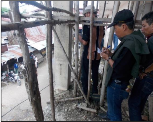
Gambar 9. Uji Hammer Test Kolom
