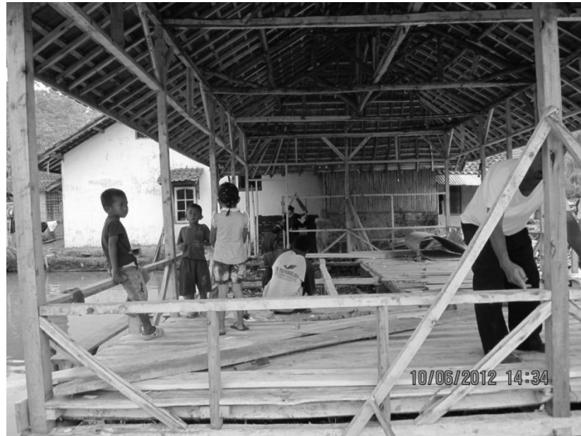
Gambar 7. Proses pembangunan Rumah Budaya. (Visitasi I, 10 Juni 2012)
