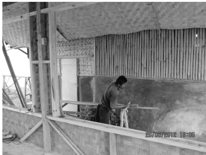
Gambar 9. Pekerja yang sedang menyelesaikan pembangunan Rumah Budaya (Visitasi II, 20 Juni 2012)
