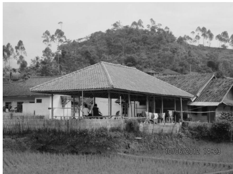
Gambar 5. Rumah Budaya yang sedang dibangun di halaman belakang rumah Bapak Undang. (Visitasi I, 10 Juni 2012)
