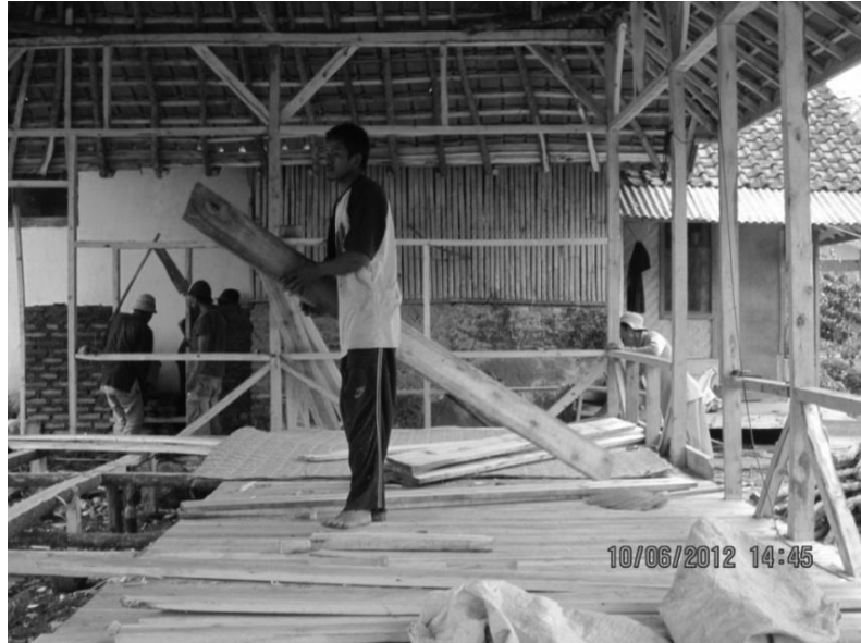
Gambar 8. Beberapa pekerja yang terlibat dalam pembangunan Rumah Budaya. (Visitasi I, 10 Juni 2012)
