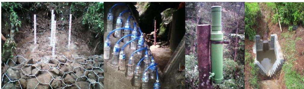
**Gambar 1.** Bangunan: gully plug, V-notch weir, penakar hujan dan bak penampung
