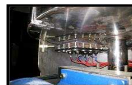
Gambar 12. Pemasangan Elemen Pemanas
