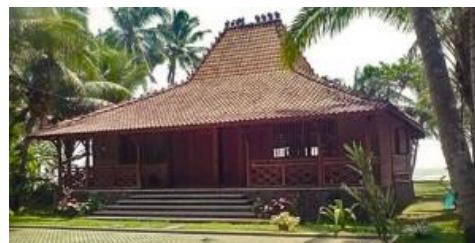
Gambar 2. Bangunan konvensional Jawa (Sumber : infobisnisproperti.com)
