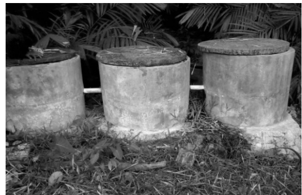
Gambar 4. Penampung air yang saling dihubungkan.
