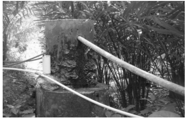
Gambar 5. Pendistribusian air dengan pipa paralon.
