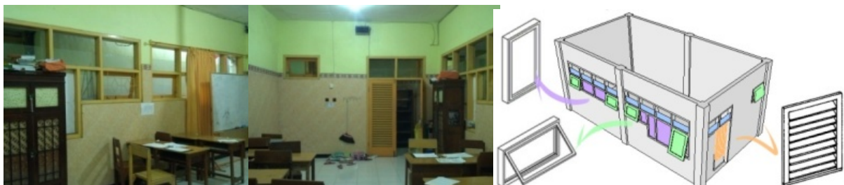
Gambar 5. Kondisi Eksisting Ruang Tipe 4
