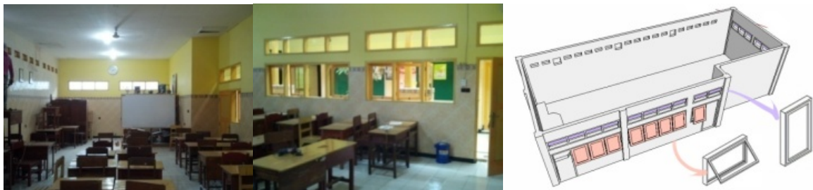
Gambar 7. Kondisi Eksisting Ruang Tipe 7
