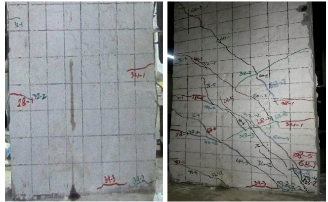
Gambar 6. Retak awal dan akhir DGK-150-2 bagian belakang dinding
