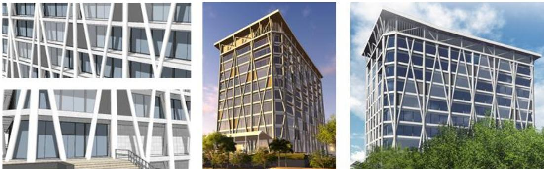
Gambar 6. Modul *Bracing* Eksterior dan Interior
