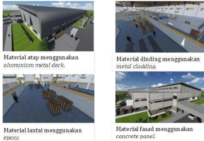
Gambar 8. Material Bangunan Industri Pengalengan Asparagus
