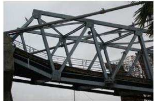
Gambar 1 Contoh Keruntuhan Jembatan Rangka Peraturan yang Digunakan
