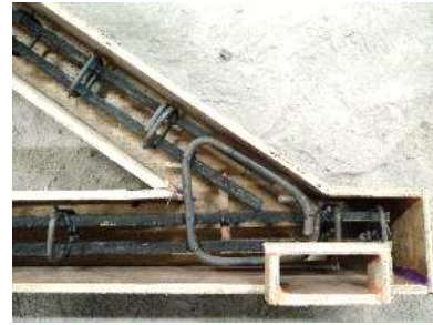
Gambar 16 Tulangan pada sambungan sudut
