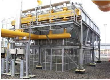
Gambar 1. Aftercooler Pada SKP PT.PGN AOSS
