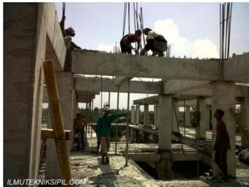
Gambar 2.2 Metode pracetak dengan sistem Bresphaka
