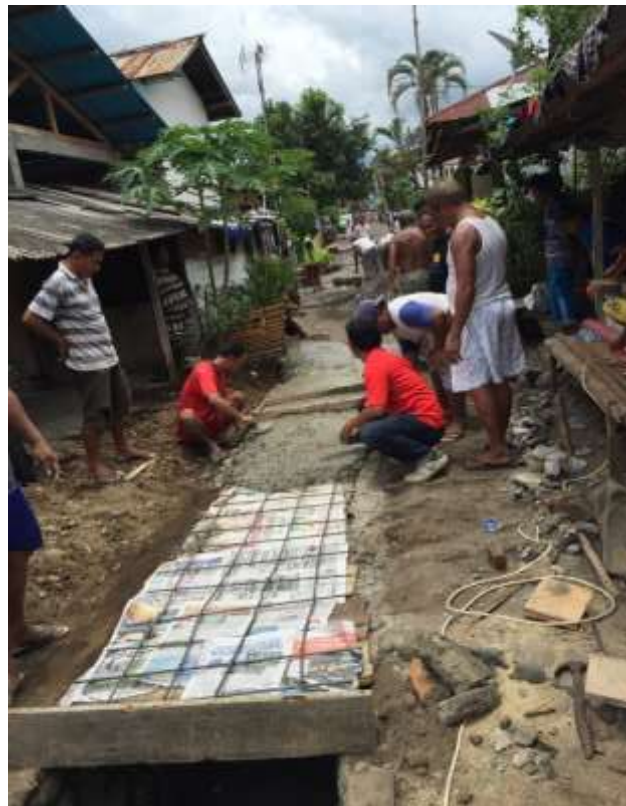
Gambar 5. Pengecoran penutup atas Drainase
