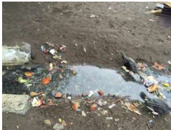
Gambar 3. Sistem drainase yang seadanya
