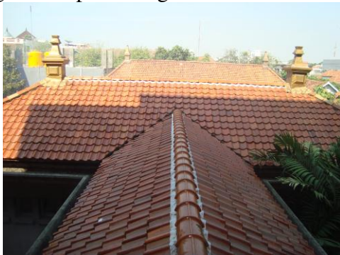
Gambar 8. Atap bangunan induk
