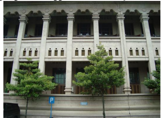
Gambar 9. Kolom eksterior bangunan
