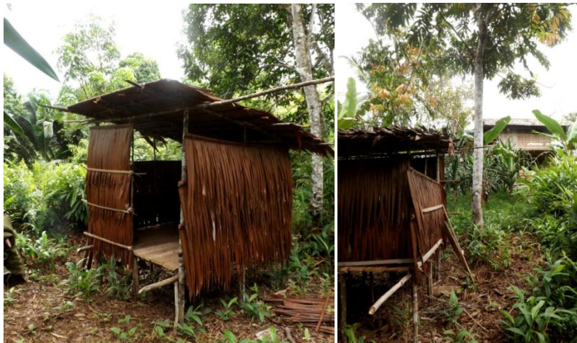
Gambar 1. Bévak (kiri); Posisi Bévak dari Rumah Panggung Utama, berjarak 25 meter (kanan) Sumber: Dokumentasi Peneliti
