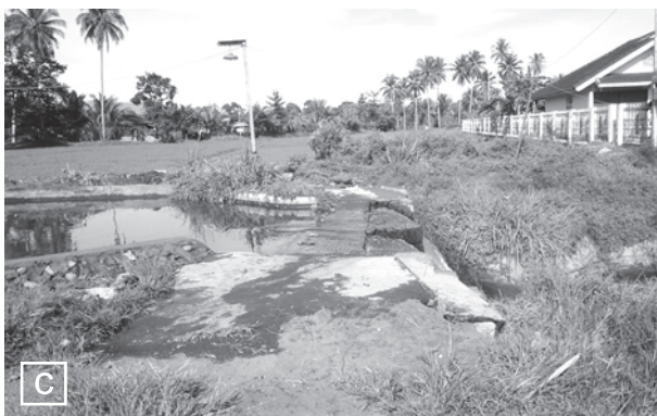
Gambar 1. Bendungan utama "water vang" (a), bangunan bagi (b) dan bendungan pada saluran yang dilakukan pemilik kolam air deras (c)
