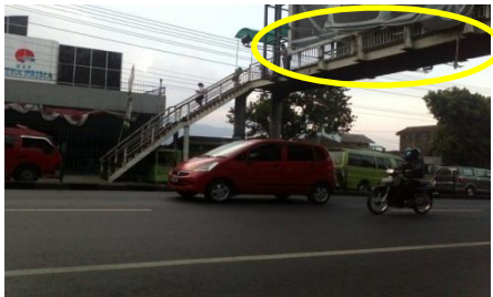
Gambar 5.3 Lokasi Pemasangan Rambu (Arah Semarang)
