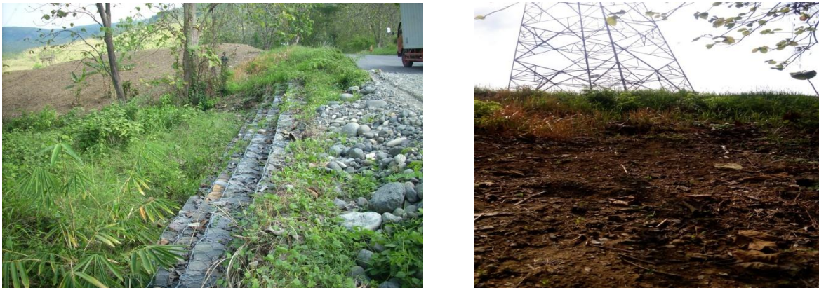
Gambar 1. Penanganan yang telah dilakukan dengan Bored pile dan bronjong.
