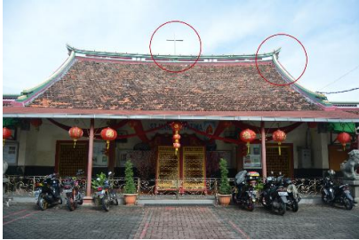
Gambar 1. Salib pada puncak atap dipasang sebagai identitas gereja dan ujung atap swallows tail merupakan khas bangunan Tionghoa
