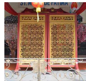
Gambar 8. Partisi ditempatkan di depan pintu masuk utama untuk menghalau cahaya masuk berlebih
