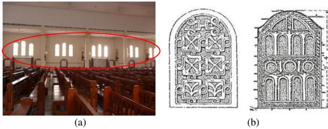
Gambar. 10. (a) Bentuk jendela di sepanjang dinding panti umat (b) Jendela gaya *Early Christian* dengan bentukkan pelengkung pada bagian ambangnya (Sumber: Fletcher 1928,p.217)
